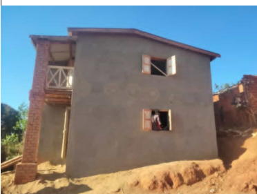
...la maison en cours de finition.
